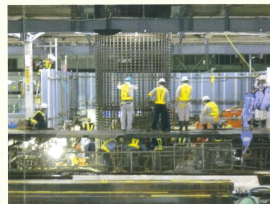
鉄筋かご建て込み
