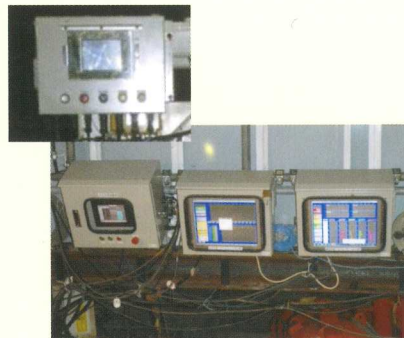
掘削管理・孔内水位管理 システムとの連携 (施工箇所リアルタイム表示)
