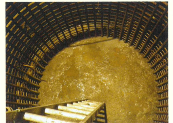
コンクリート打設完了
