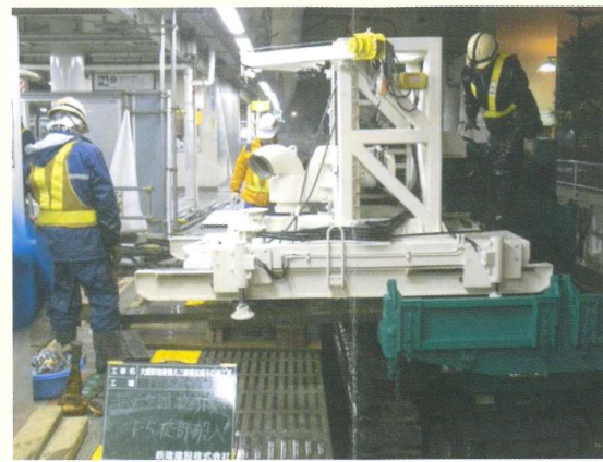
レベリングジャッキとスキッド スライド機構による移動
