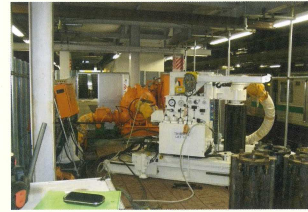
掘削機据付(ホーム上)
