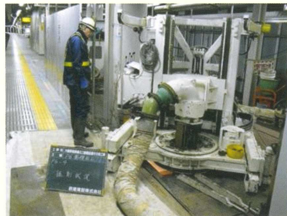
掘削状況(ホーム上)
