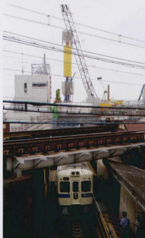
営業線近接施工
