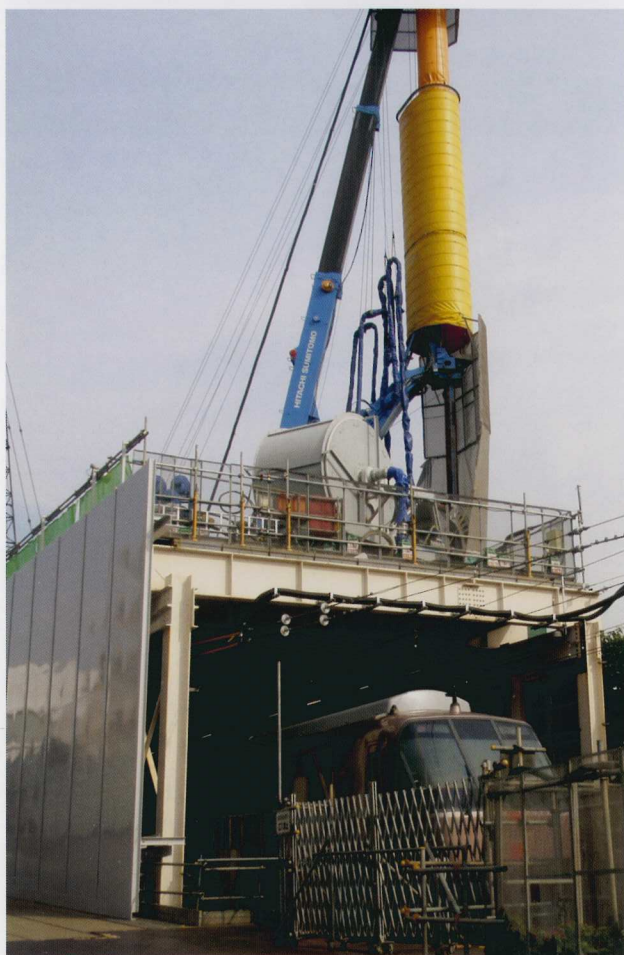
営業線溝台上施工
