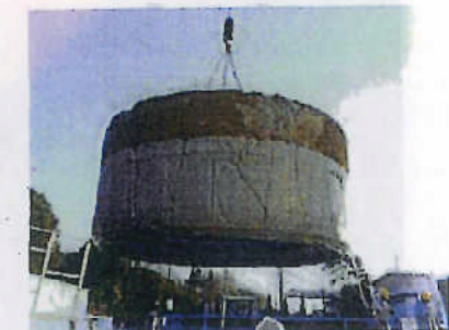
シール撤去 (裏込め材充填状況)
