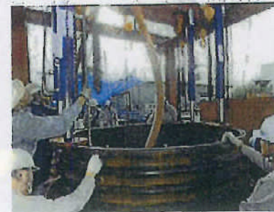
ジャッキによる押し込み状況
