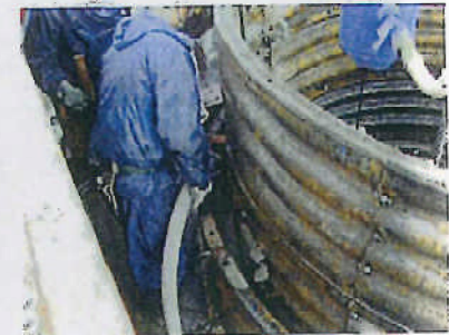
裏込め充填状況
